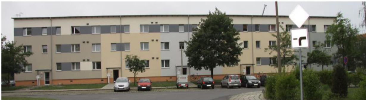
Abbildung 47: Zustand nach Sanierung und Teilrückbau (Straßenansicht) [BTU]
