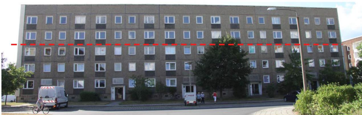
Abbildung 46: Zustand vor Sanierung und Teilrückbau [BTU]
